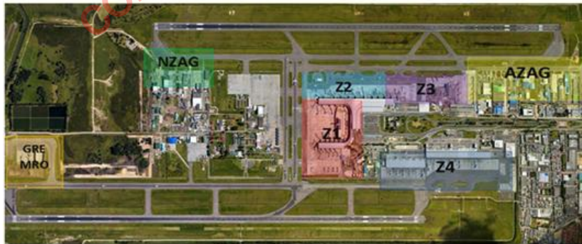
Figura 1: Programación de Barrio con maquina FOD
